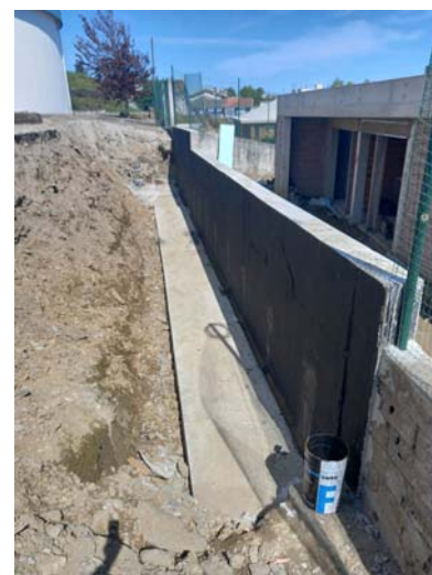
Reconstrução de parte do muro de vedação do reservatório Fonte da Senhora, Valongo
