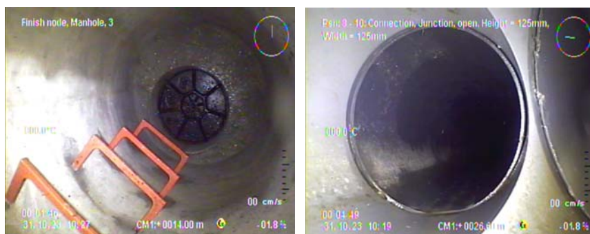
Anomalias nas infraestruturas identificadas com recurso a inspeção vídeo
