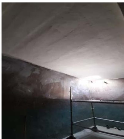
Reconstrução de parte do muro de vedação do reservatório Fonte da Senhora, Valongo
