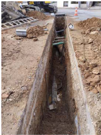
Remodelação do coletor e caixa na Rua Cavada da Molha, em Valongo
