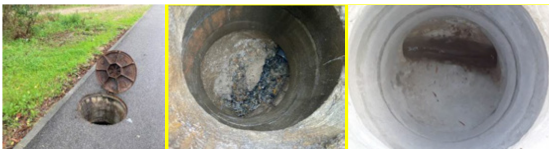
Exemplo de reabilitação de caixa de visita – rua Ribeiro do Cambado (V1), Valongo
