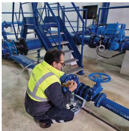
Determinação de Cloro Residual num reservatório
