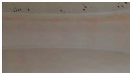
RESERVATÓRIO BAGUIM CÉLULA DIREITA DEPOIS DA LIMPEZA E DESINFEÇÃO
